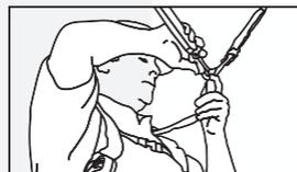
Le système Alsipercha permet à l'opérateur de changer d'ancrage avant de se décrocher du premier Alsipercha, en maintenant ainsi la sécurité à tout moment.
